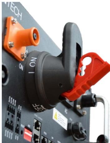
7. Schalte sämtliche MBMS aus, indem du alle „Haupt- bzw. Kippschalter“ nacheinander in die „Off-Stellung“ versetzt.
